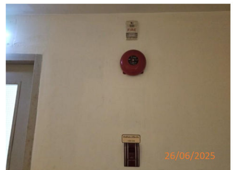
อุปกรณ์ส่งสัญญาณแบบกระดิ่ง (Alarm Bell)
